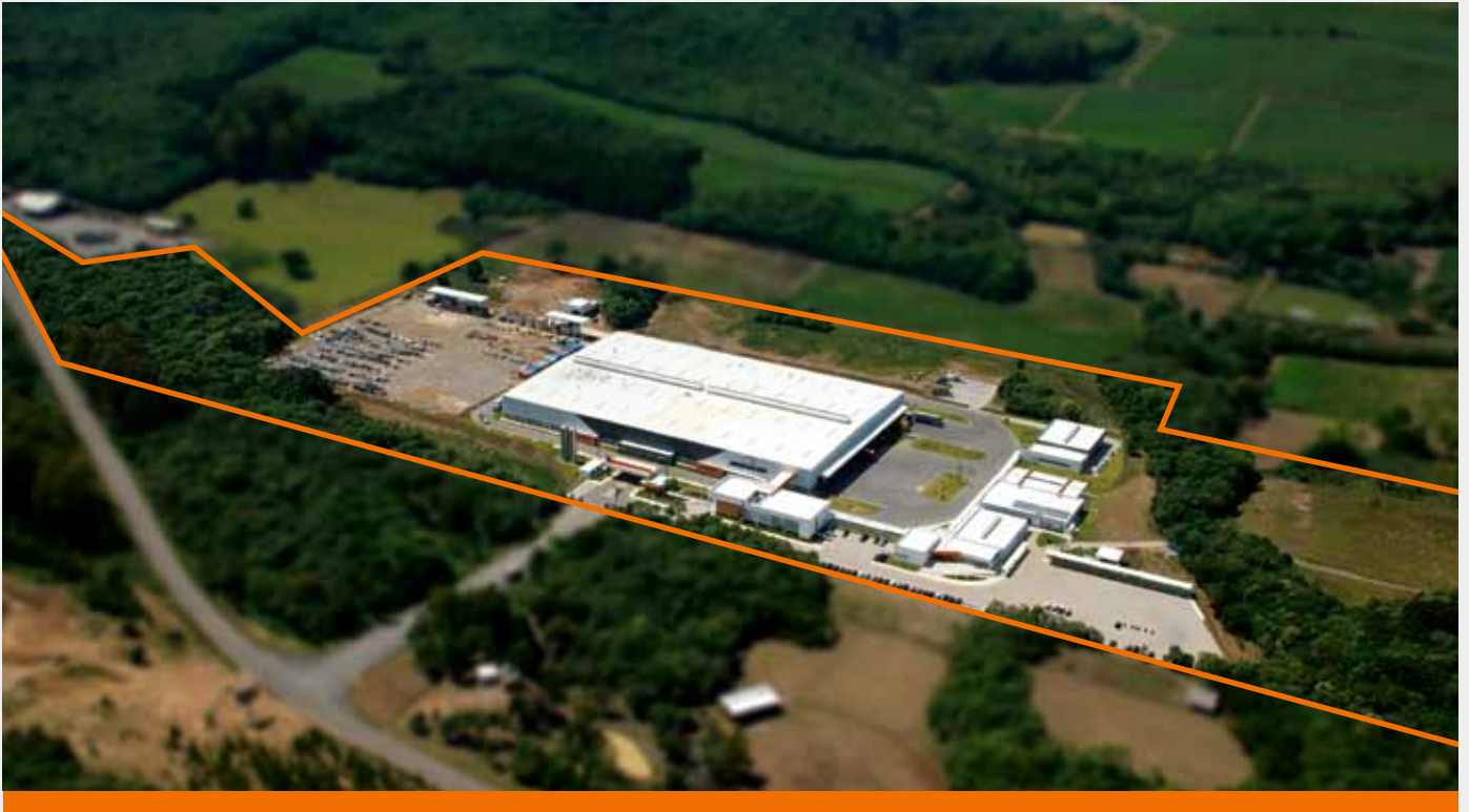
Instalação do novo parque fabril.
